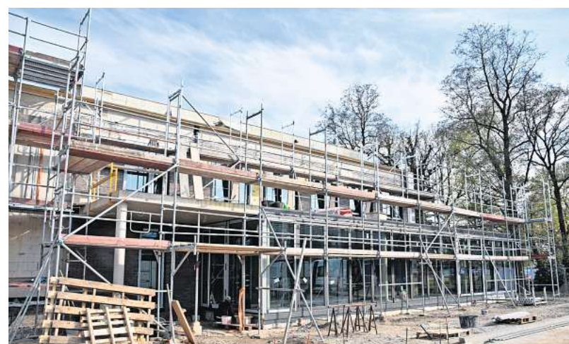
225 Sitzplätze soll die L'Osteria bald im Innen- und Barbereich auf zwei Stockwerken bieten.
